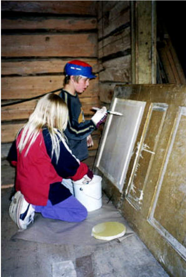
En av kvarnens spegeldörrar renoveras och målas efter traditionell teknik.
